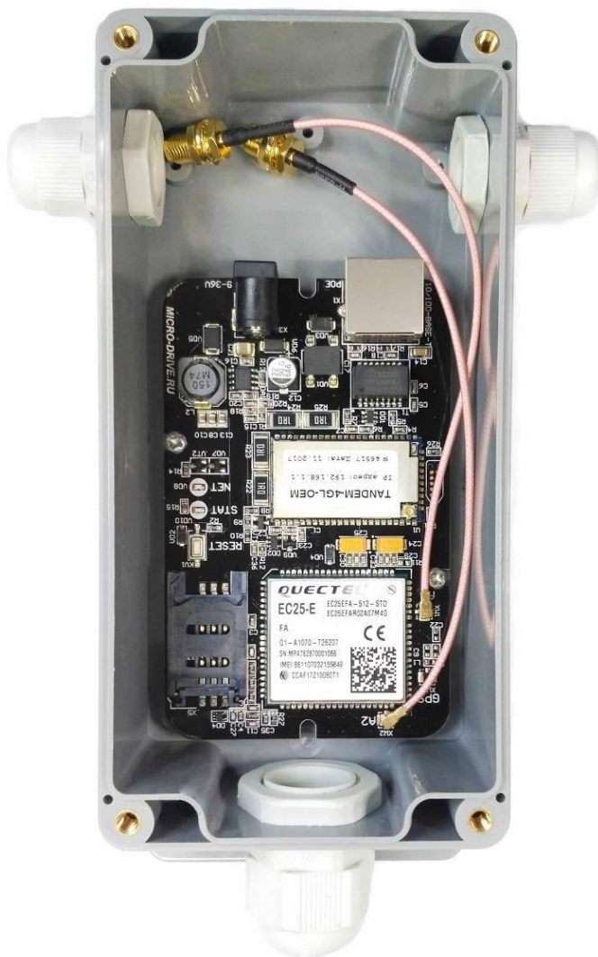
Рис.6.2. Монтаж в гермобоксы «Gainta».
